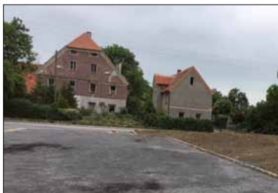
Zrealizowano pierwszy etap zagospodarowania terenu w Małuszowie. Wykonano 1200 m kw. podbudowy na miejsca postojowych przy kościele
