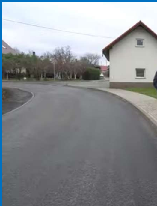
Droga po przebudowie
