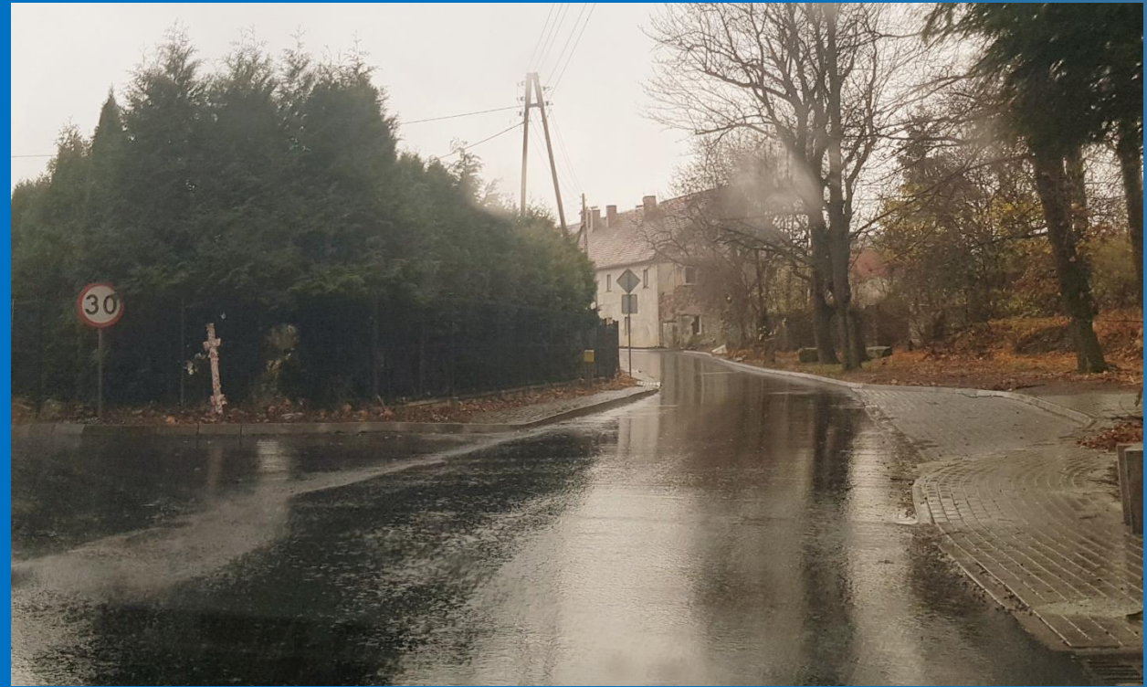
Stan po przebudowie drogi
